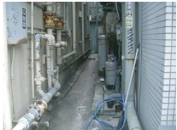
▲建物の間の路地
